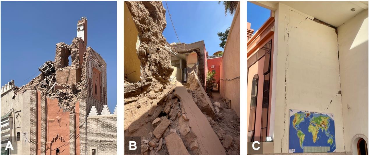
La Figura 5 ilustra los impactos del terremoto del 8 de septiembre en edificios en Marrakech. A) Edificio colapsado en la plaza Djemaa el Fna, en la ciudad antigua (11 de septiembre de 2023). B) Casa colapsada en la zona residencial (Rue de la Bahía) de la ciudad antigua (11 de septiembre de 2023). C) Pared agrietada del salón de conferencias Geopark 2023, Complexe Culturel et Administratif des Habous (10 de septiembre de 2023).
