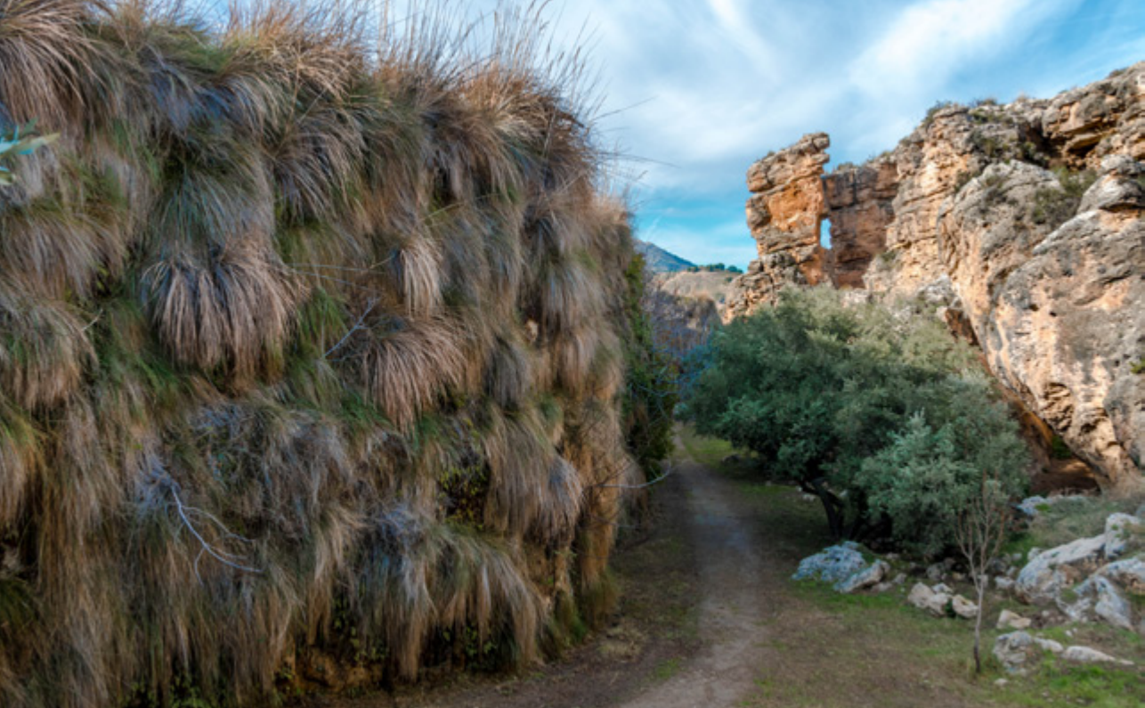
Figura 12. Crecimiento de comunidades vegetales en las paredes del acueducto del Toril. El acueducto del Toril es un auténtico jardín vertical, en el que las plantas crecen sobre rocas que no necesitan millones de años para formarse. La porosidad de la roca travertínica que lo forma permite que esté siempre húmedo y que crezcan comunidades de plantas perfectamente adaptadas a la salinidad y temperatura de estas aguas. Una de ellas es el endemismo Limonium Alicunense , reconocible por sus pequeñas flores violáceas, que sólo crece aquí. La precipitación del carbonato cálcico alrededor de los tallos y hojas de las plantas nos regala también un jardín fosilizado en el que podemos ver qué plantas vivían en la zona desde hace cientos de miles de años.
