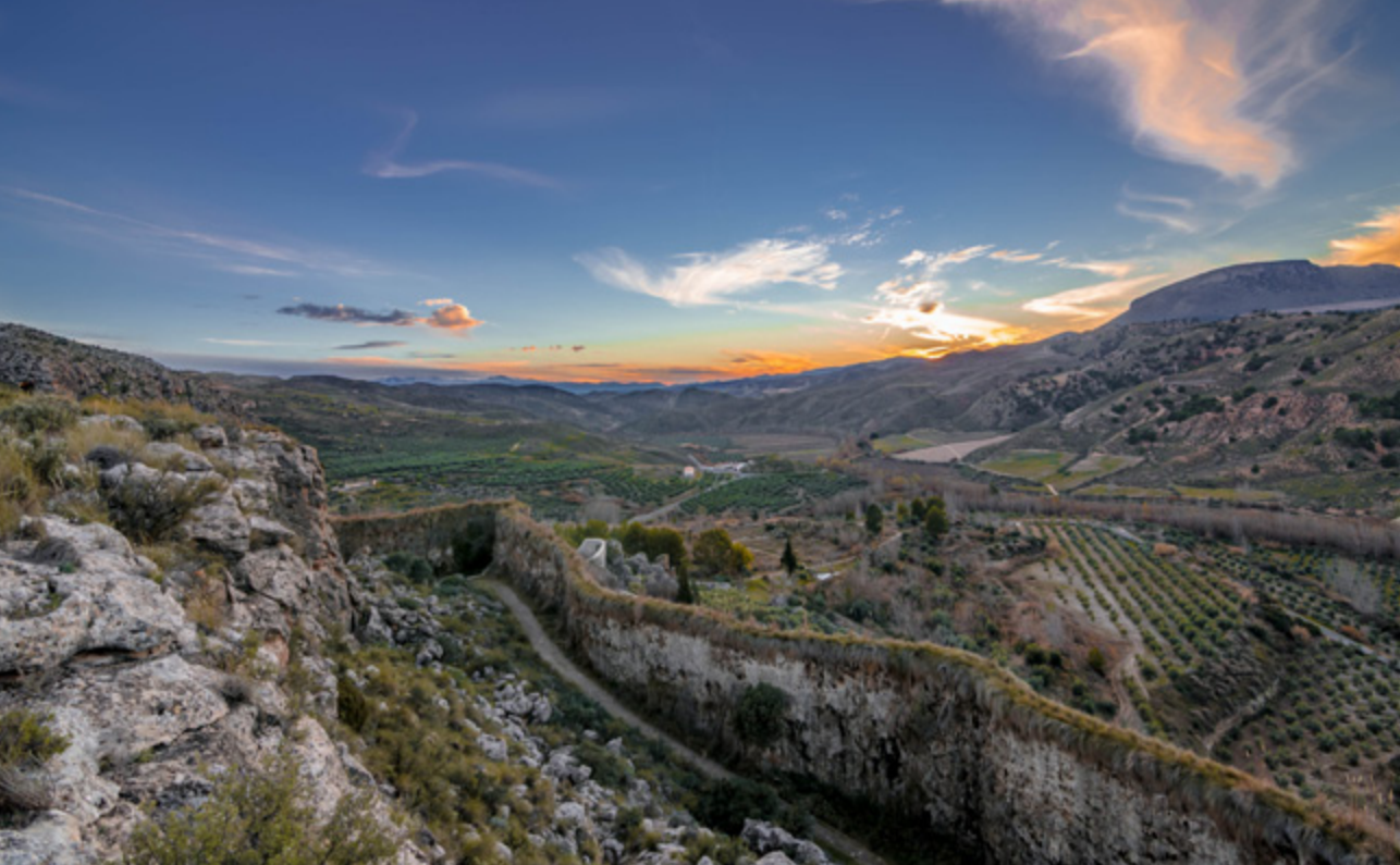
Figura 11. Panorámica del muro de travertinos que constituye el acueducto del Toril. Las rocas que se observan en un primer plano a la izquierda pertenecen a la plataforma de travertinos más alta del sector, que tiene una edad de 205.000 años.
